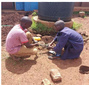
Schweissen der Rohrleitung
