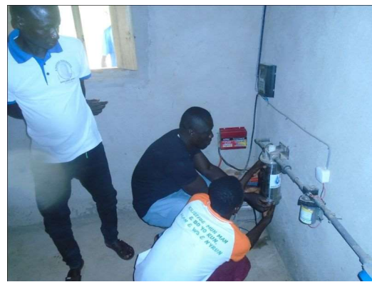
Montage der Anlage im Schulhaus
