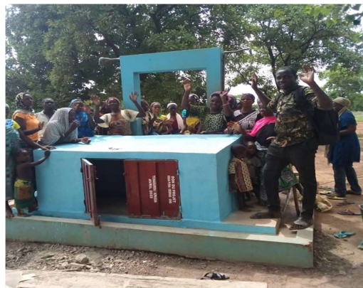
Die Trinkwasseranlage ist fertig!
