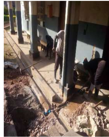
Verlegung neue Rohre
