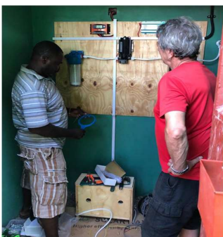
Waterflow wird installiert
