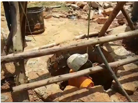
Arbeiten am Bohrloch
