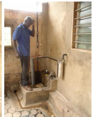
Mit PVC Rohren wurde die Wasserinstallation ausgeführt
