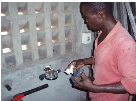
Mit PVC Rohren und Fittings wurde die Installation durchgeführt
