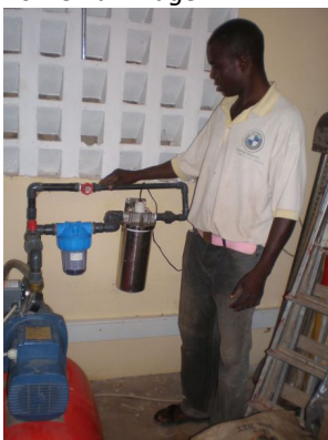
Das Bild zeigt den togolesischen Klempner nach der Installation des Vorfilters in der Klinik.
