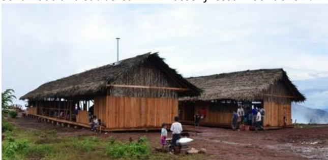
Das Schulhaus, welches die Architektur-Studenten aus Stuttgart und Peru gebaut haben und jetzt in Betrieb ist.
