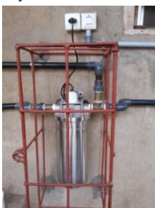
Damit das Waterflow200 Durchlaufsystem wie auch der Wasserhahn nicht mehr als Kinderspielzeug benützt werden konnte musste es mit einem Gittergerüst geschützt werden .
