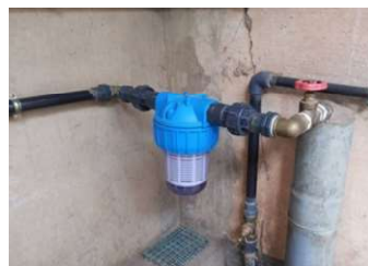
Hier wurde das Vorfilter im Waisenhaus in KPalimé eingebaut
