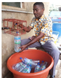
Damit das Waterflow200 Durchlaufsystem wie auch der Wasserhahn nicht mehr als Kinderspielzeug benützt werden konnte musste es mit einem Gittergerüst geschützt werden .
