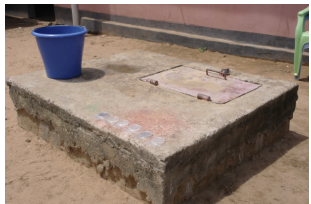
Aus dieser Regenwasserzisterne wird Regenwasser entnommen und in Zukunft zu Trinkwasser für die Schüler und das Lehrpersonal verarbeitet.
