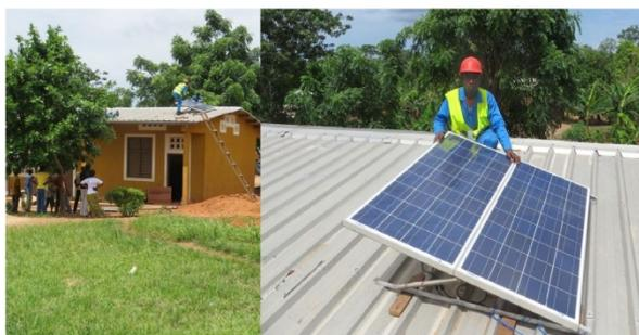
Da das Dorf Blendou Kangahkro keinen Stromanschluss besitzt, wurde von „aqua pura“, zum ersten Mal in der Vereinsgeschichte, eine 240 Watt Solaranlage mit Batterie, Stromwandler etc. für den ganzen Betrieb der Trinkwasseranlage gespendet. Das Bild zeigt die Montage des Solarpanels auf dem Dach des Dorfschulhauses durch Spezialisten aus der Stadt Soubré.
