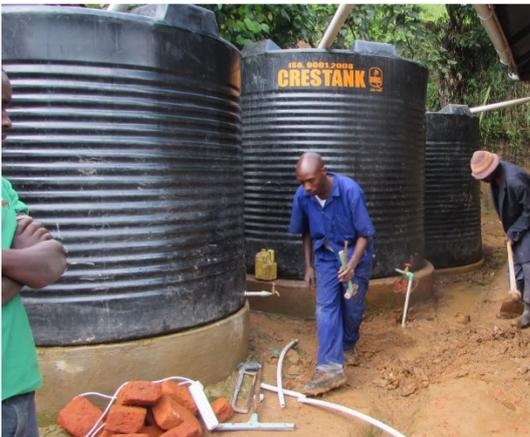
In diesen Wassertanks wird das Regenwasser gespeichert. Der Sanitärinstallateur beim Anschluss der Wasserleitung an das Waterflow-System
