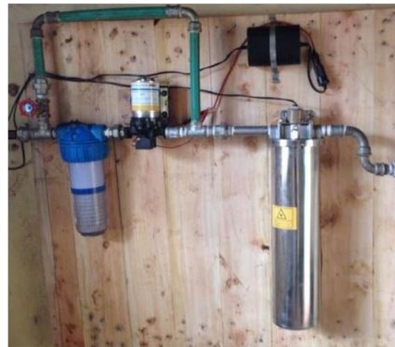
Das Waterflowsystem wurde neu mit einem Carbonvorfilter und einer Shurflopumpe ausgerüstet. Dank des Vorfilters muss nun der Waterflowfilter weniger gereinigt werden. Mit der Shurflopumpe fließen nun ca. 400 Liter Trinkwasser pro Stunde.
