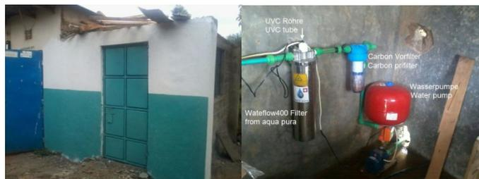
Hinter dieser Metalltüre wurde das Filtersystem montiert. Die Wasseranalyse zeigt, dass das Trinkwasser absolut frei von Cholera, E.coli und Salmonellen ist.
