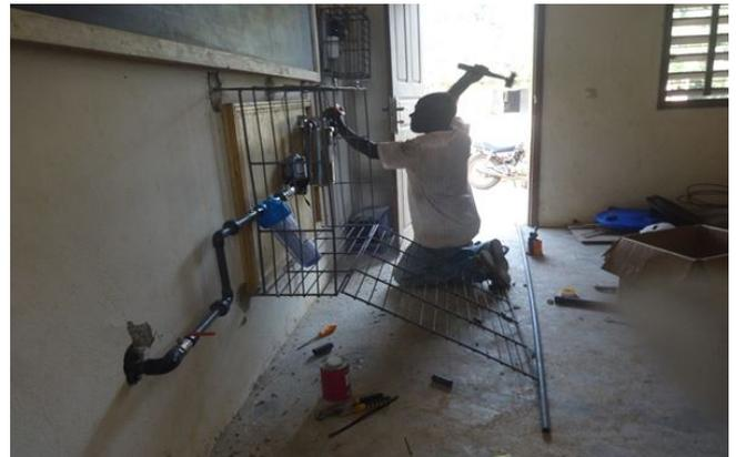
Die Waterflow-Anlage wird - mit den Wassertanks verbunden - in einem Schutzgehäuse montiert.
