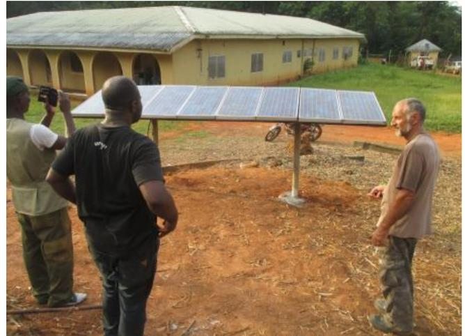
**Die Wasserpumpe und die UV-C Röhre werden nicht mit einem Dieselgenerator sondern - umweltgerecht - mit einer Solaranlage als Energiequelle betrieben**
