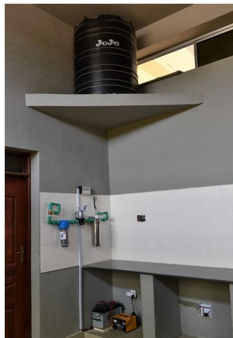
*Aqua pura System ergänzt mit Ladegerät und Batterie als Notstrompuffer*
