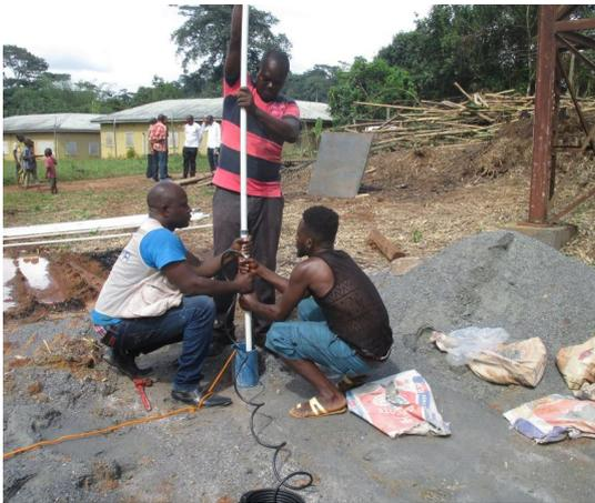
**Aus einem Bohrloch von 110 m Tiefe kann Wasser mit einer Pumpe in einen neu erstellten Wasserturm mit zwei 3000 Liter Tanks gepumpt werden.**
