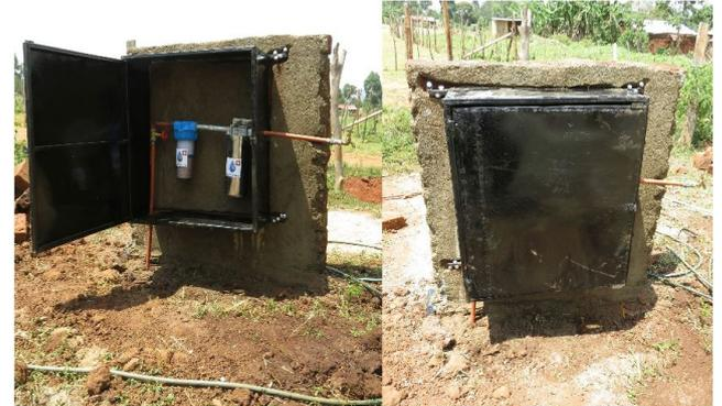
*Die Backsteinmauer wird gebaut und die Wasserfilter-Anlage wurde auch bei diesem Projekt zum Schutz in einem abschliessbaren Metallkasten montiert.*
