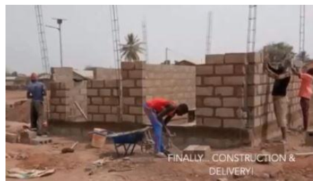
Bau des «Cabano» für die Tanks und die Waterflowanlage
