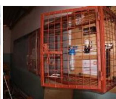
Im Schulhaus von Goshene wurde die Wasserentkeimungsanlage von aqua pura eingebaut. Zum Schutz der Anlage wurde sie in einem Gitterschrank untergebracht.
