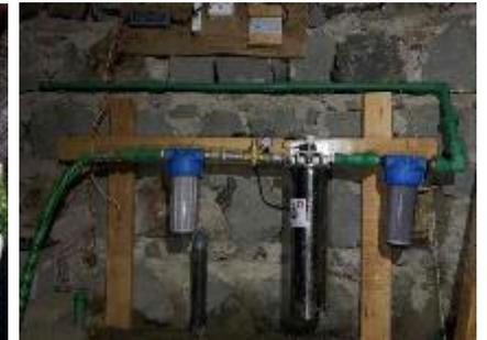
Die Trinkwasserversorgung war ein Teil des Projektes. So wurde eine Zisterne gebaut, um das Regenwasser von den Dächern aufzufangen. Über der Zisterne entsteht der Unterstand für das Waschbecken. Auf der Rückseite der Mauer ist Platz für das Waterflow System von aqua pura, mit dem die Wasseranlage ergänzt wird. In Trockenzeiten kann die Zisterne auch mit Wasser aus der nicht immer zuverlässigen offiziellen Wasserleitung der Stadt gefüllt werden.
