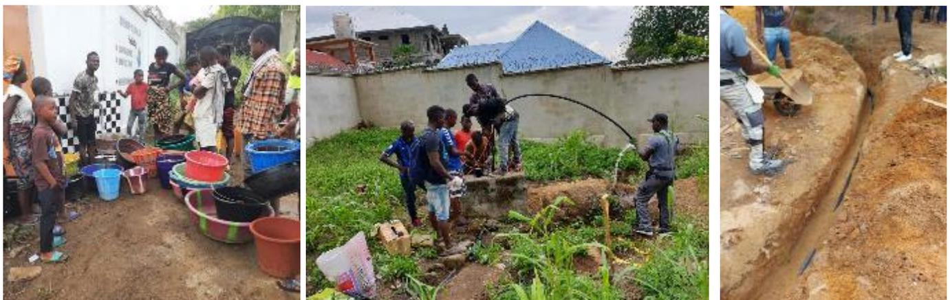
Die öffentliche Wasserstelle ausserhalb der Mauer welche das Bohrloch (ca. 55 Meter tief) umschliesst, ist bereits in Betrieb. Um die Trinkwasserqualität auch nach längeren Lagerzeiten in den Tanks zu gewährleisten, ist auch hier der Einbau eines Waterflow Systems im Gang. Die umfangreichen Installationsarbeiten wie z.B. der Wasserleitung in Richtung Dentalstation und Hospital sind unter Mithilfe der Bevölkerung bereits weitgehend abgeschlossen.
