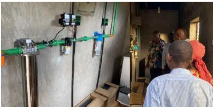
Unter der Leitung von Peter Safari Shehe (Mitbegründer von pro Ganze) wurde die von aqua pura gespendete Wasseraufbereitungs-Anlage mit einem Waterflow 500 Filter und einer UV-C Entkeimungsröhre professionell installiert. Die Solar-Anlage als Energiespender liefert den erforderlichen Strom für den Betrieb des Waterflow Systems. Jetzt wir aus Regenwasser sauberes Trinkwasser.
