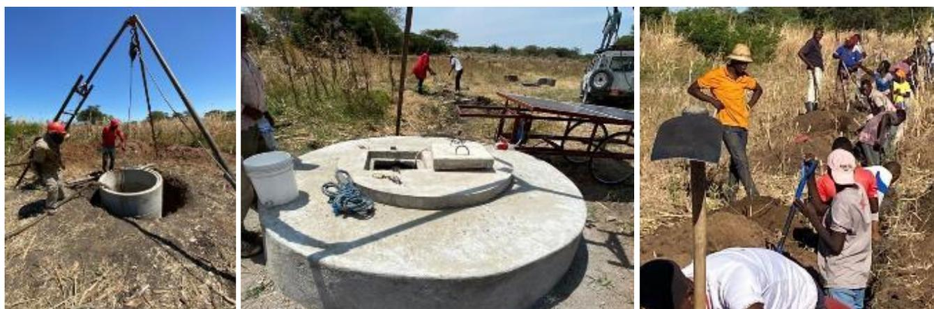
Kompetenz im Bau von Wasserentnahmestellen direkt am Fluss, kreative Ideen zur bedarfsmässigen und sicheren Stromversorgung der Tauchpumpe durch ein transportables Solarpanel, engagierter Einsatz der Dorfbewohner bei der Verlegung einer Rohrleitung vom Fluss zur Entbindungsstation...
